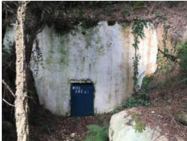
Fotografia 25 – Mina de água n.º 7 tipo Paredão (sistema do Ribeiro da Mula)
