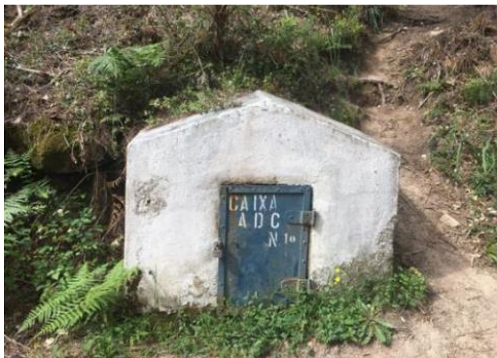
Fotografia 22 – Caixa de visita n.º 1 (Acampamento Base Pedra Amarela- sistema do Ribeiro da Mula)
