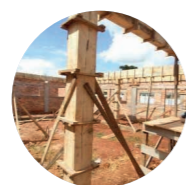
Local para construção de infraestruturas
