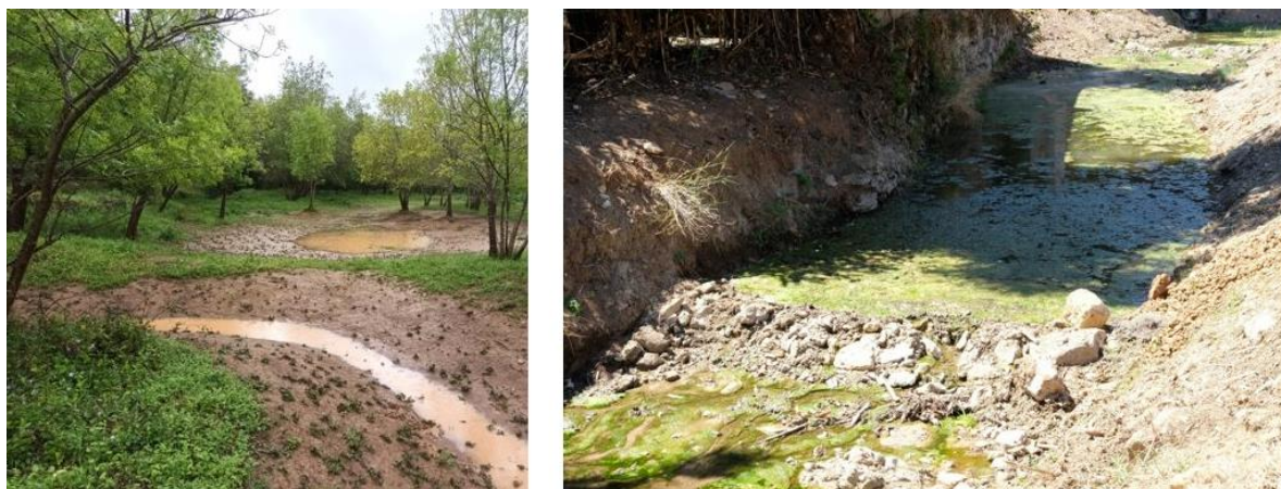
Figura 28 - Criação de bacias de retenção e quebras hidráulicas
